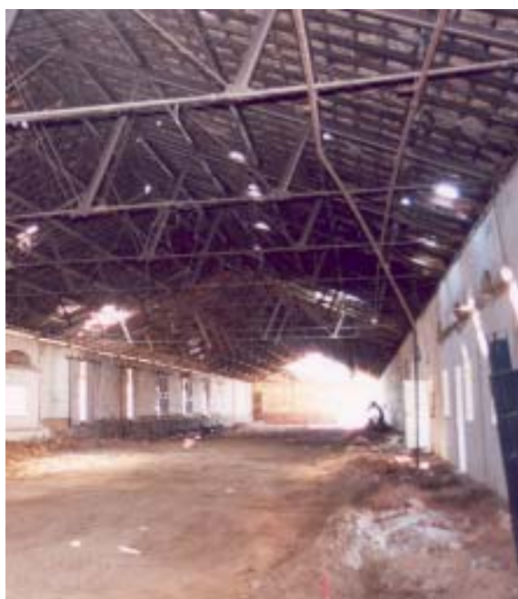
Barracão onde será construído o Ceprocamp
