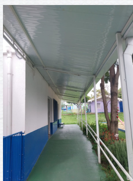
Cobertura de interligação
