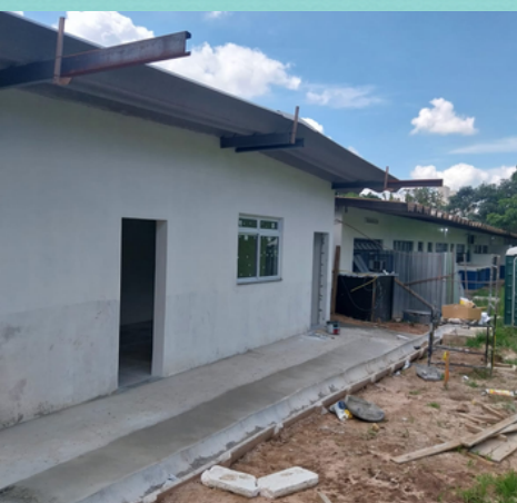
Vista Externa (Fundos), Conexão Prédio Antigo
