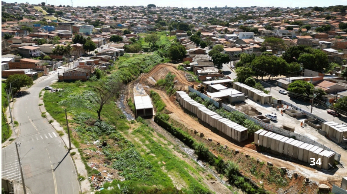
Foto: PAC do Córrego Santa Lúcia Etapa II -Pavimentação e Drenagem - PMC (2024)
